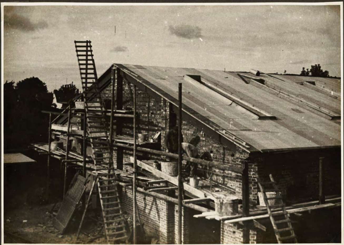
Neubau Drahtseilerei Mitte August
