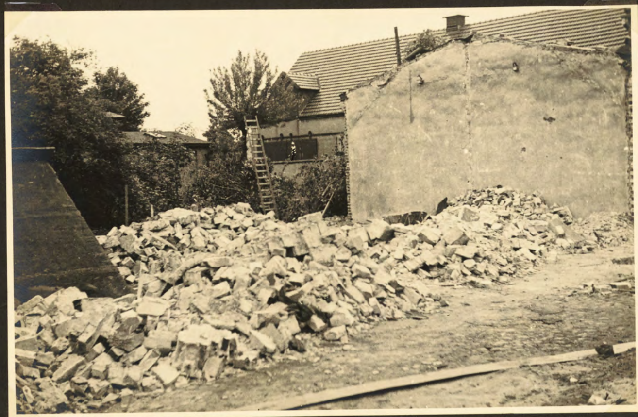
Abbruch des Hanflagers Juni 1936
