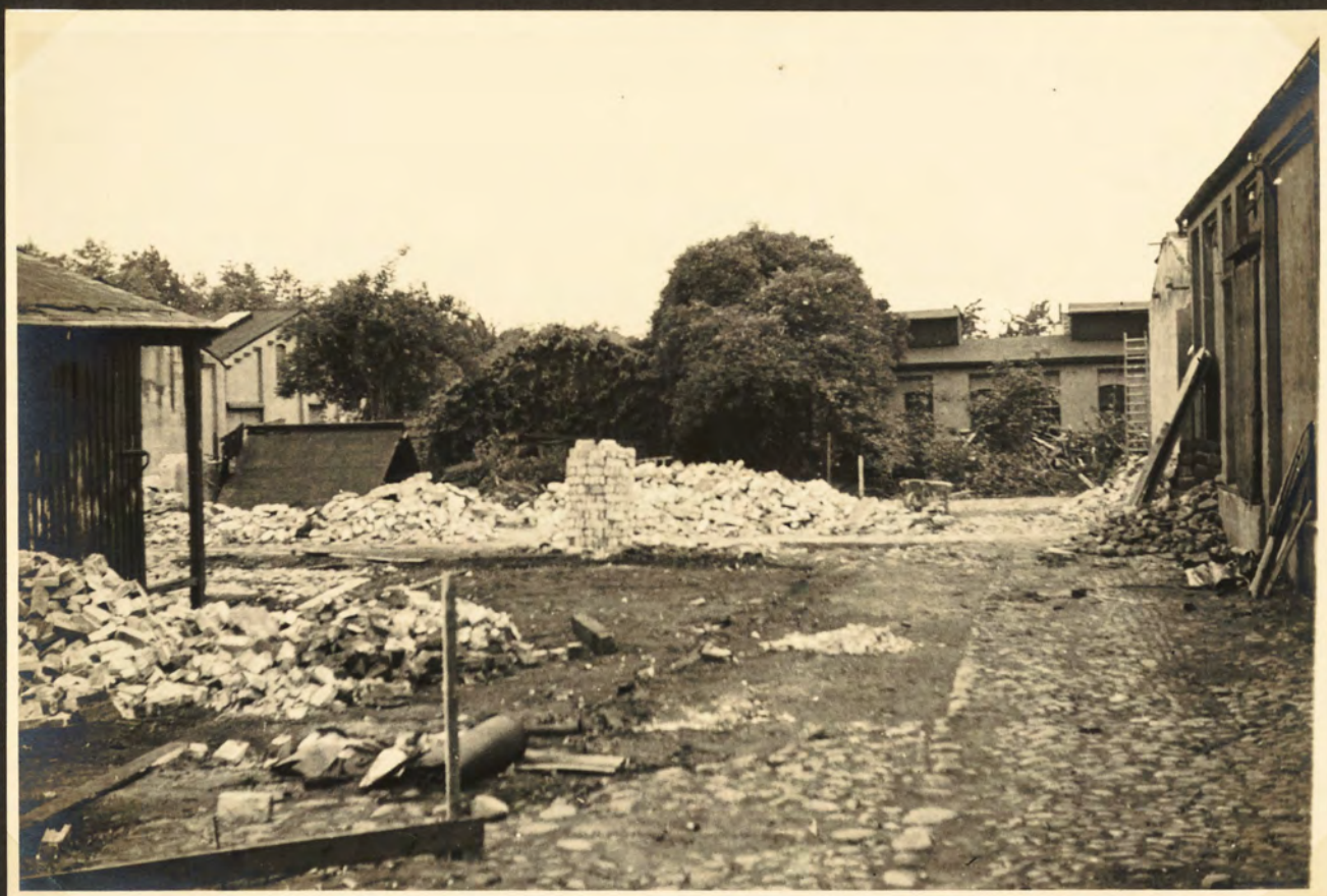
Umbau, Blick auf den Hechelschuppen
