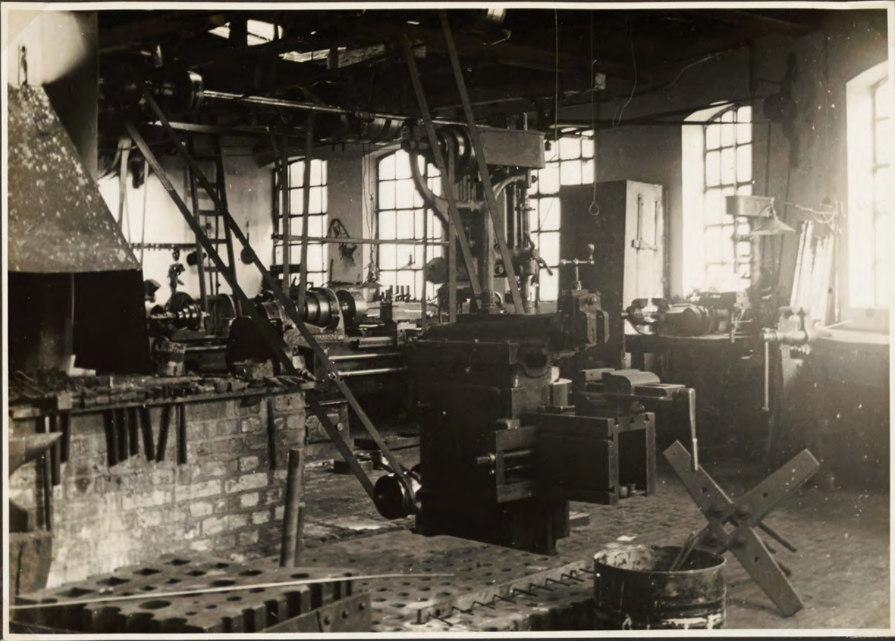
Schlosserei nach dem Umbau
