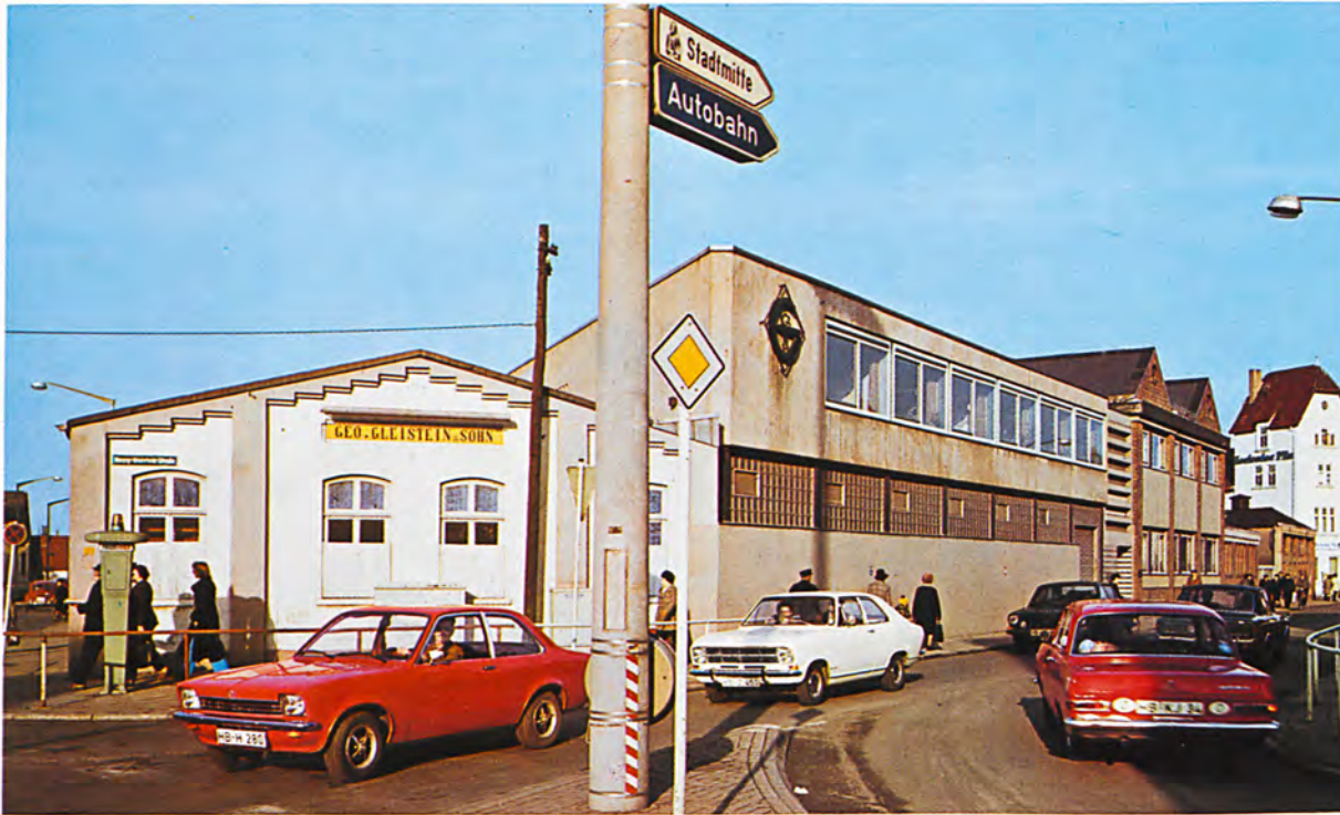
Frontansicht mit Verwaltungsgebäude Front view with administration building
